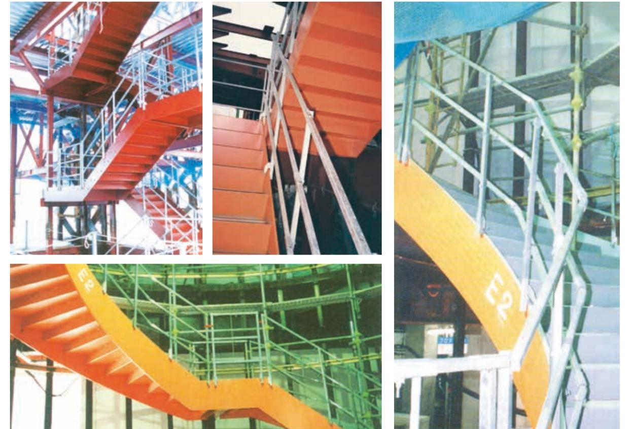
鉄骨階段用鋼製メッシュ踏板
