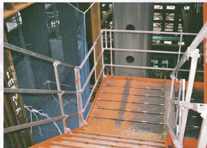
鉄骨階段用鋼製メッシュ踏板
