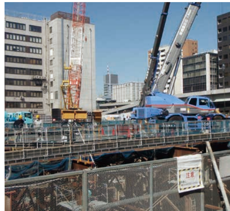
切梁・構台併設設置事例
